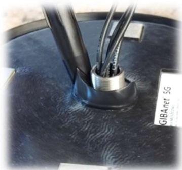
8. Führen Sie die Kabel durch das Loch und legen die Antenne lose auf das Dach (nicht anpressen!). Die Antenne liegt auf der äußeren Dichtung, **die Klebefläche sollte sich in diesem Schritt noch nicht mit dem Dach verbinden.**
